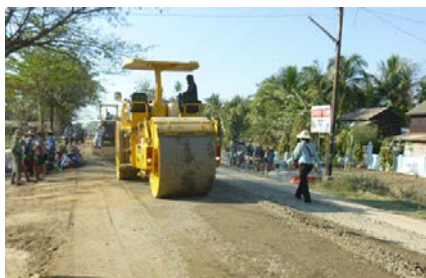
路盤締固め
