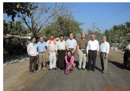
終了した試験施工区間
