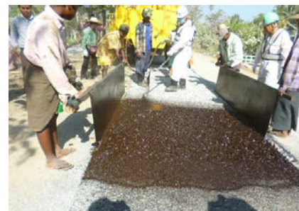
アスファルト乳剤散布
